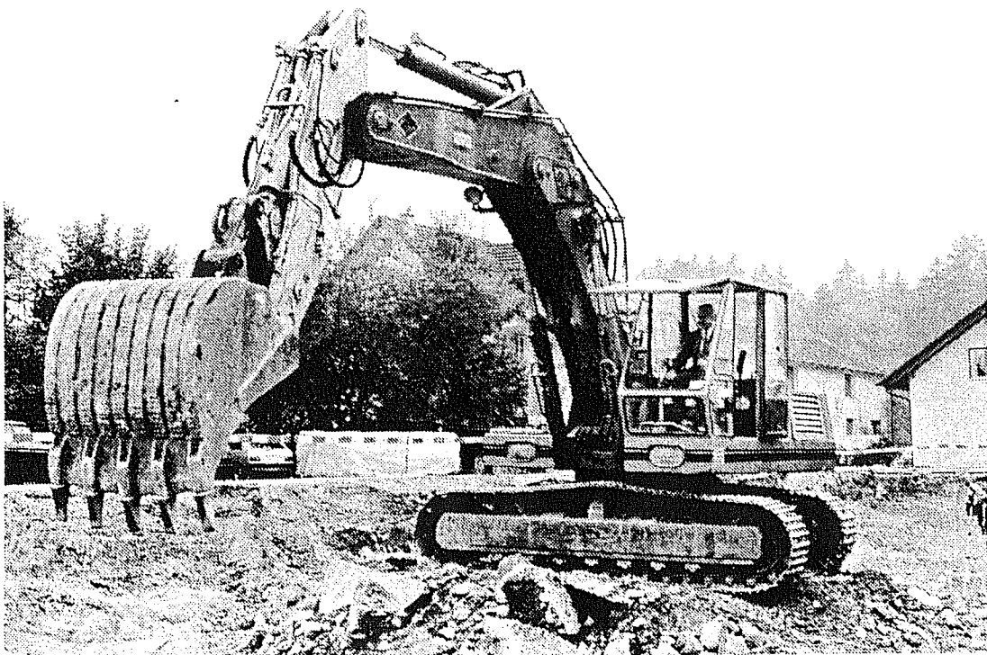
Konrad Frischknecht beim ersten Spatenstich für den Neubau der Werap AG in der «Schwarz» in Bubikon.
